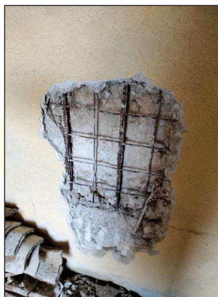
Fig. 11: Saggio muratura
