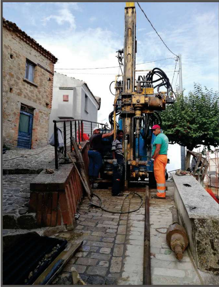
settembre 2024 Perforazione con sonda a rotazione e carotaggio continuo, a circolazione d'acqua, spinta alla profondità di 30 metri.
