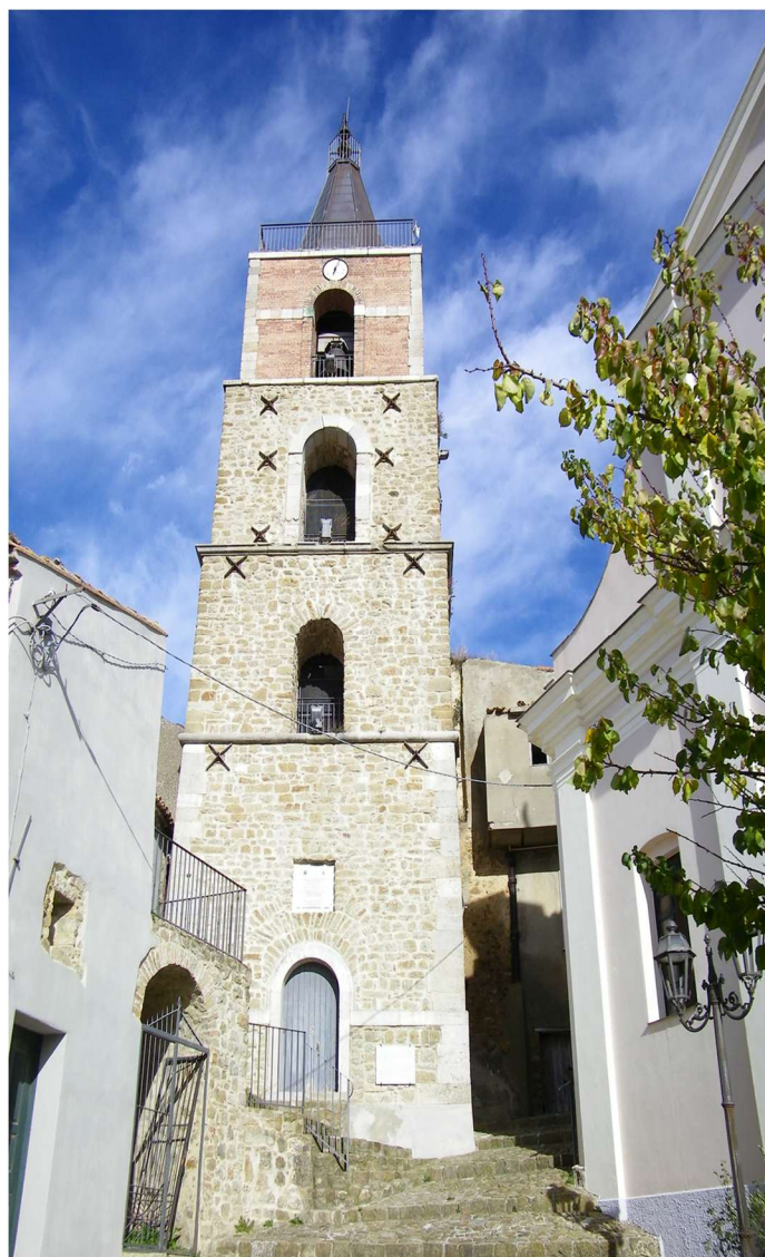
Img 2): foto del prospetto sud
